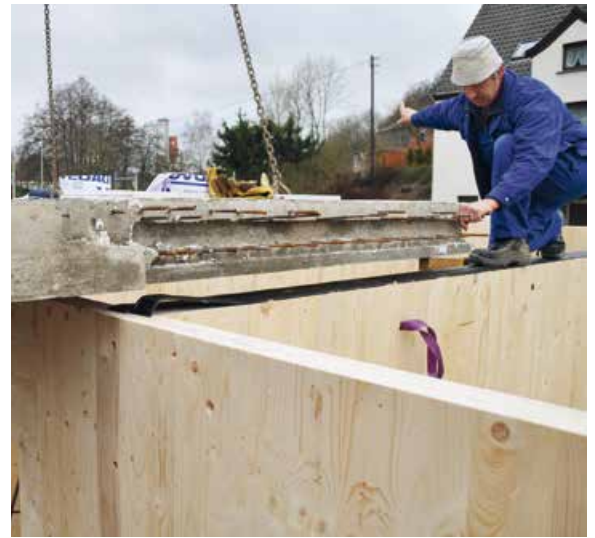
◀ Auf einem hölzernen Erdgeschoss aus Brettsperrholzwänden ruht die Stahlbetondecke
